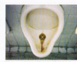
男子小便器の尿石付着状況 (3/18) 設置2週間後の尿石除去状況 (4/7)
